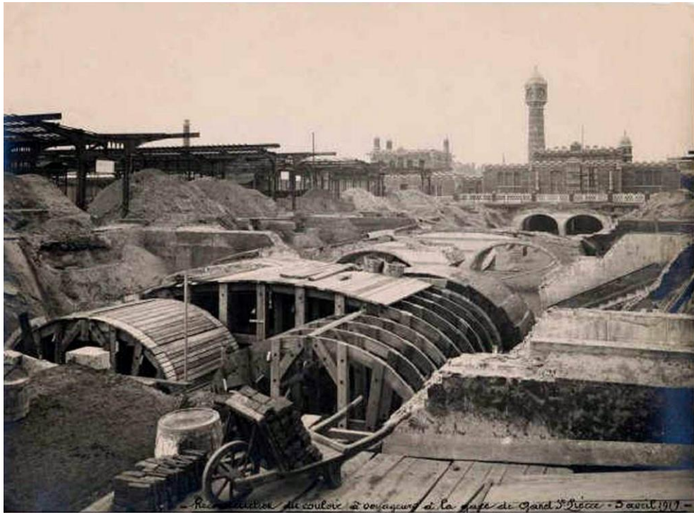
Figuur 3. Zicht op het onderzoeksgebied bij de aanleg van de tunnels in 1919.
