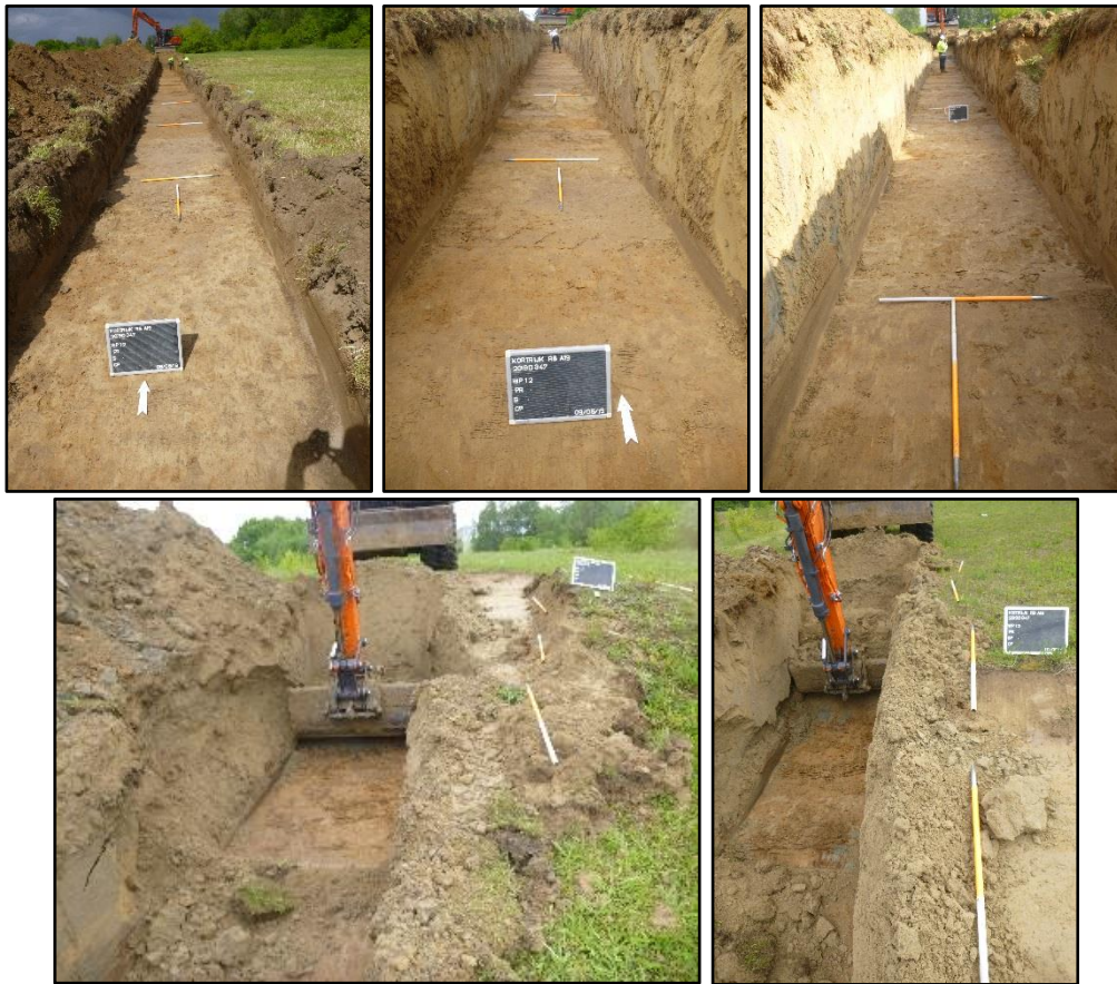
Figuur 129: overzichtsfoto's van werkput 12 (ABO nv 2019)
