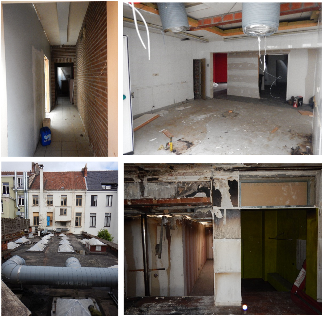
Figuur 4. Zicht op de achterliggende ruimtes en de dakconstructie (@Hembyse).
