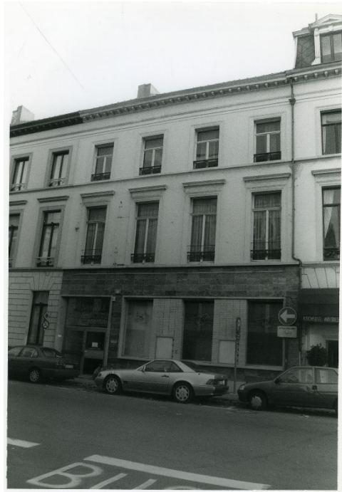
Figuur 3. Zicht op de Zuidstationstraat 31-33 (©Beeldbank Gent).
