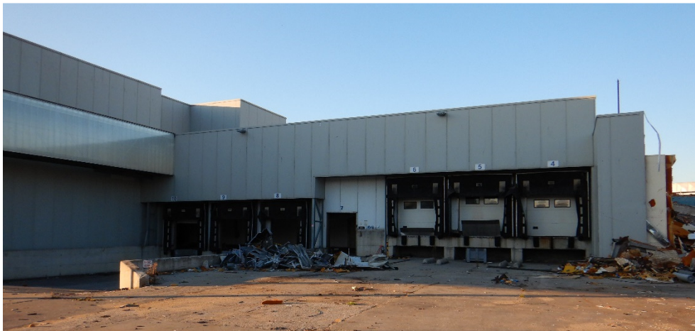
Figuur 4. Zicht op de weegbrug en de laadkades (foto genomen in noordoostelijke richting, boven) en zicht op de laadkades ten zuiden van gebouw O (foto genomen in noordelijke richting, onder, © Hembyse).
