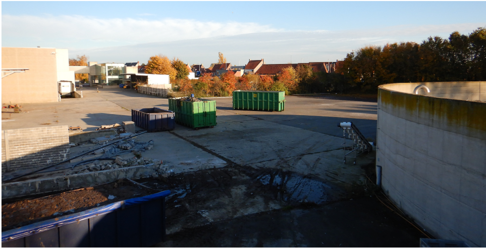
Figuur 16. Zicht op het zuidelijke deel van het onderzoeksgebied vanop het slibbekken.
