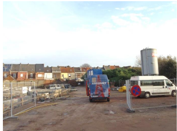
Fig. 6: De noordelijke zijde van het plangebied wordt momenteel gebruikt als werfzone (23 november 2016)
