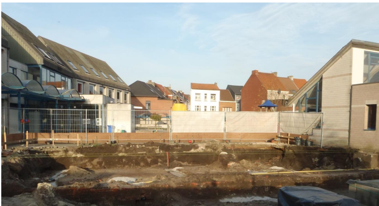
Figuur 22: Zicht op de bodemopbouw in de bouwput van de nieuwbouw voor de Sint-Pietersschool (23 november 2016)
