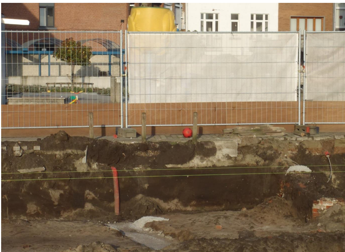
Figuur 23: Zicht op de bodemopbouw in de bouwput van de nieuwbouw voor de Sint-Pietersschool, detail (23 november 2016)
