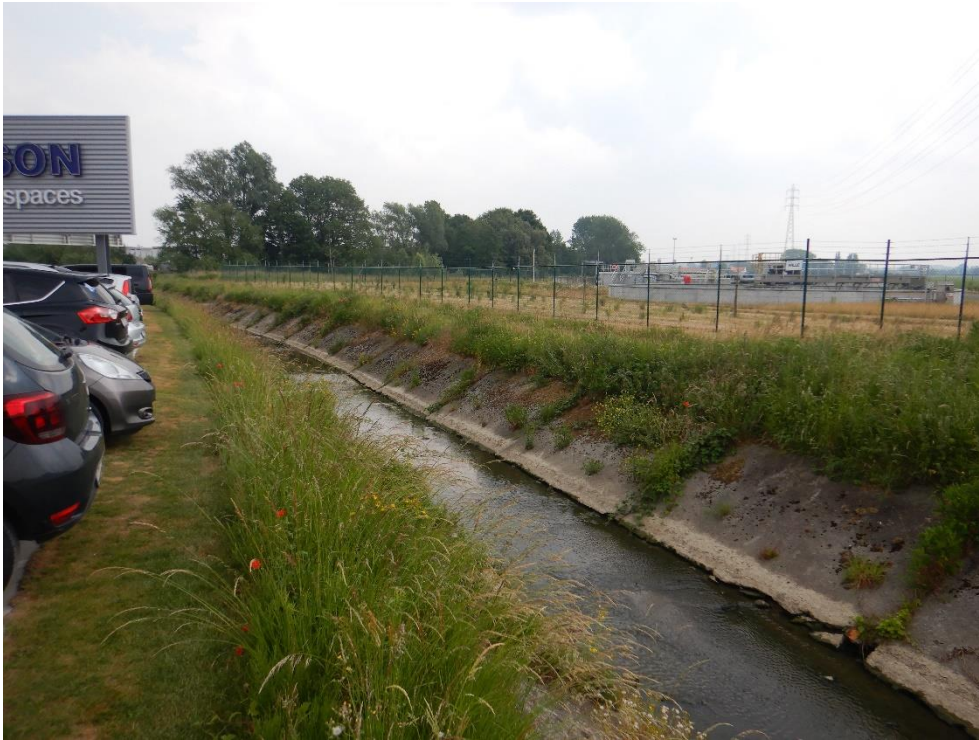
Figuur 10. Zicht op de Maalbeek tussen de verharde parking en de rioolwaterzuiveringsinstallatie.
