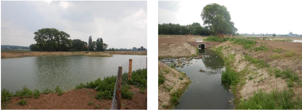
Figuur 8. Zicht op het aangelegde waterbekken ten zuiden van het onderzoeksgebied.
