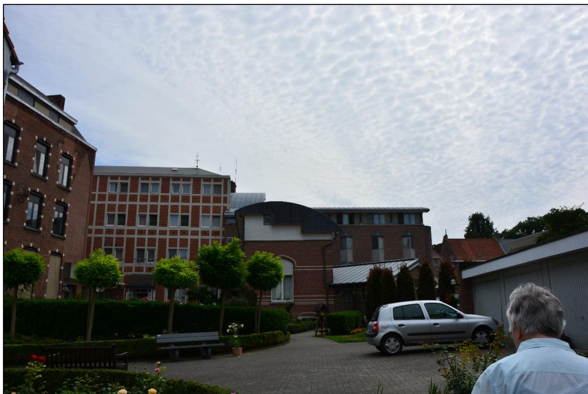
Figuur 12: Noordelijke gevel van de zuidelijke gebouwen (1970)
