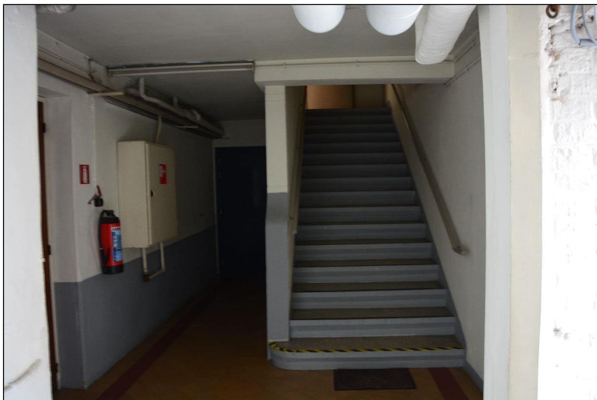
Figuur 17: Kelderverdieping onder het centrale kloostergebouw
