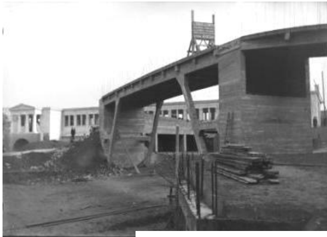
Bouw van de brug, Beeldbank KMDA
