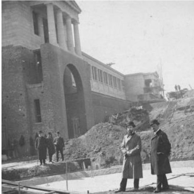
Tijdens de aanleg van de zuidwestelijke hoek, Beeldbank KMDA
