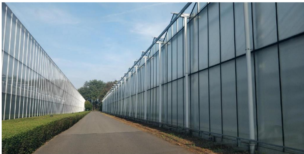
Figuur 5: Foto van een bestaande serre (links) en te slopen serre (rechts) met ertussen de toegangsweg 6
