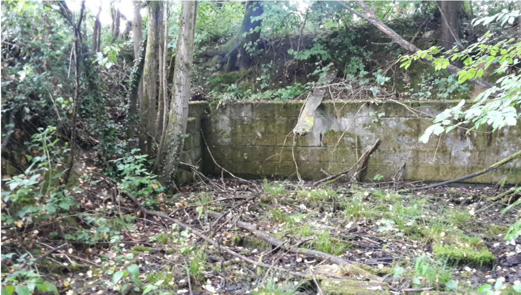
Afb. 10. Detailfoto van de kelder.
