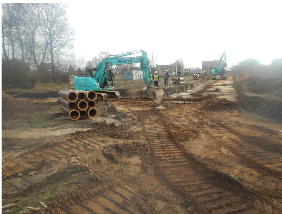
Figuur 2: aanleg van nutsvoorzieningen voor de uitvoer van het onderzoek.
