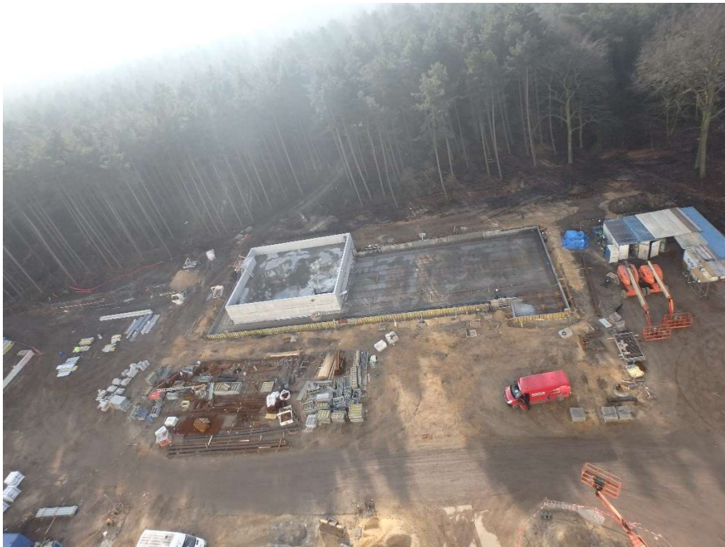
Figuur 3c. Situatiefoto's gemaakt tijdens het bouwen van de hallen en koeltoren in zone 4.
