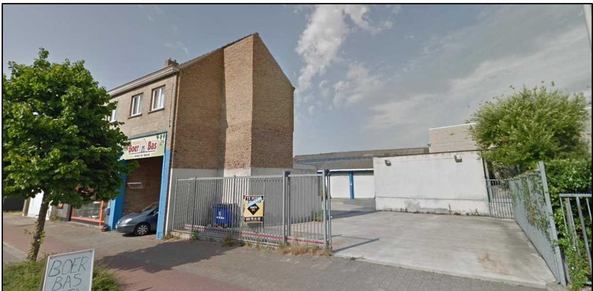
Figuur 4 Zicht vanuit het zuiden op woning 6 met bijhorende verharding en achterliggende loodsen (bron: https://www.google.com/maps )
