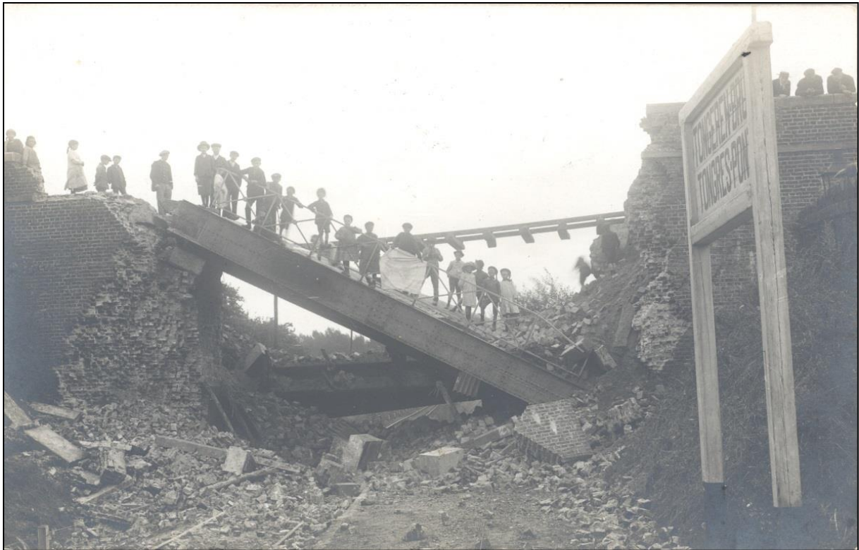
Afb. 31: Foto van de tijdens WO I opgeblazen spoorwegbrug aan de Bilzersteenweg. De foto werd genomen vanaf de westzijde van de brug, als dusdanig geïdentificeerd door het bord 'Tongeren-brug/Tongres-Pont' (Bron: SAT 12.03.04-IV-040).
