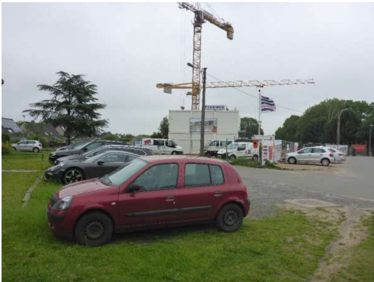
Figuur 4: bestaande toestand. Het projectgebied is momenteel ingericht als werf en parking
