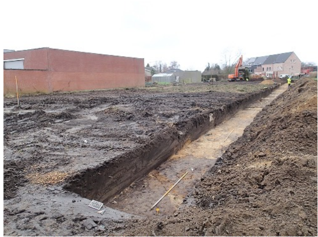
Fig. 6 Zicht op het terrein vanaf het zuiden. © Fodio
