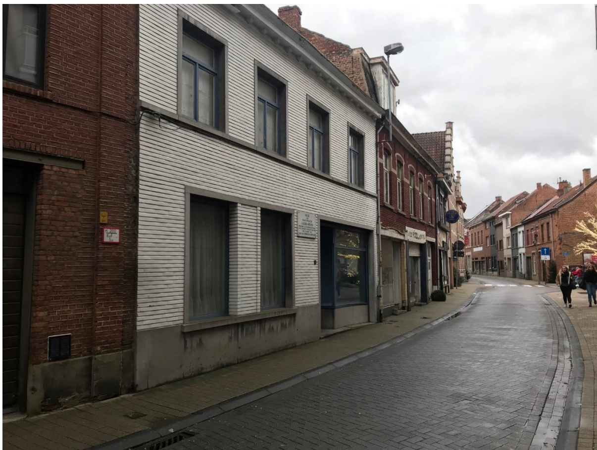
Figuur 5: Voorgevel plangebied: overzicht 2 11
