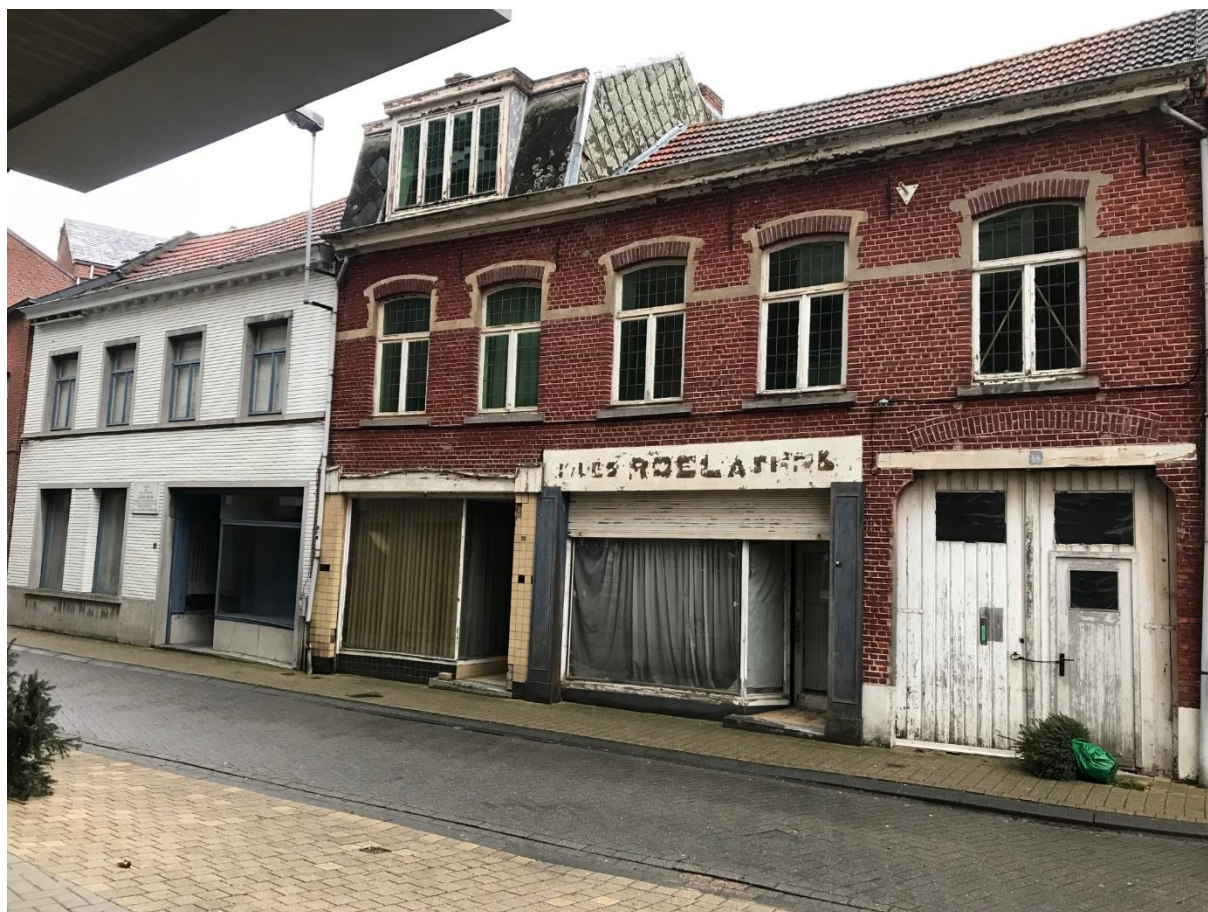
Figuur 4: Voorgevel van het plangebied: overzicht 1 10
