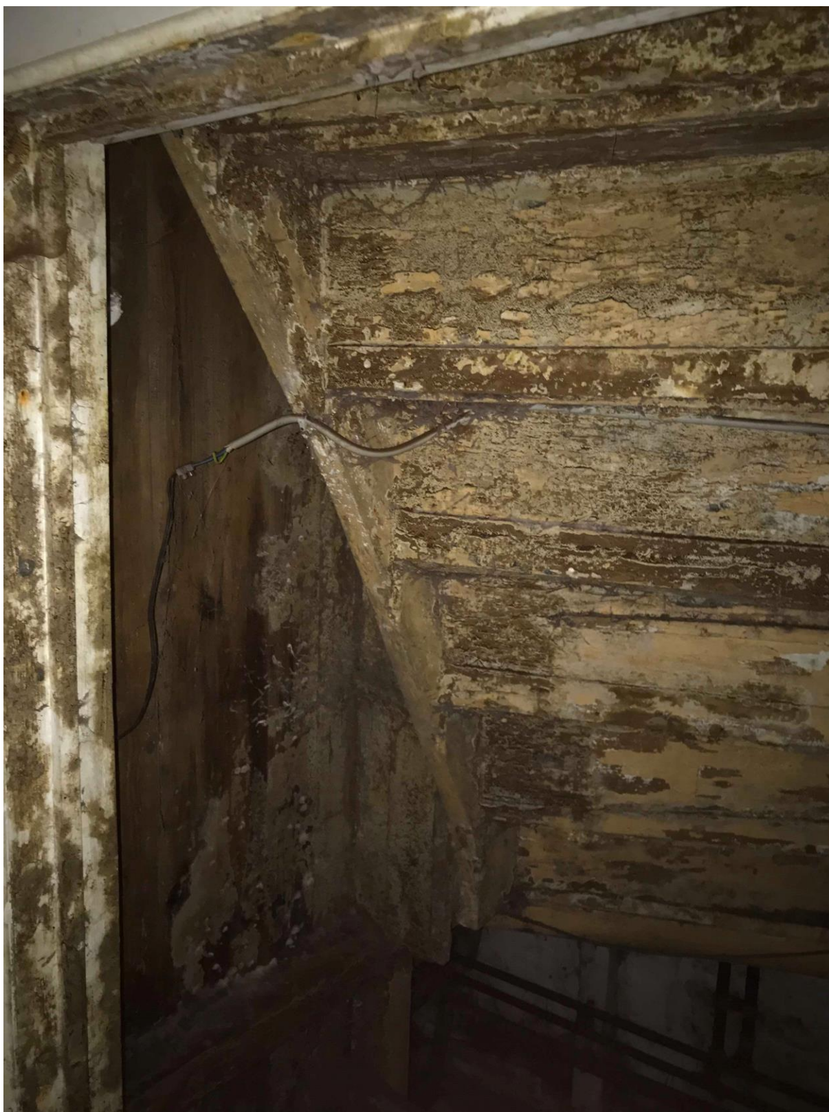
Figuur 9: Ingang kelder woonhuis 10 met een trap erboven 15
