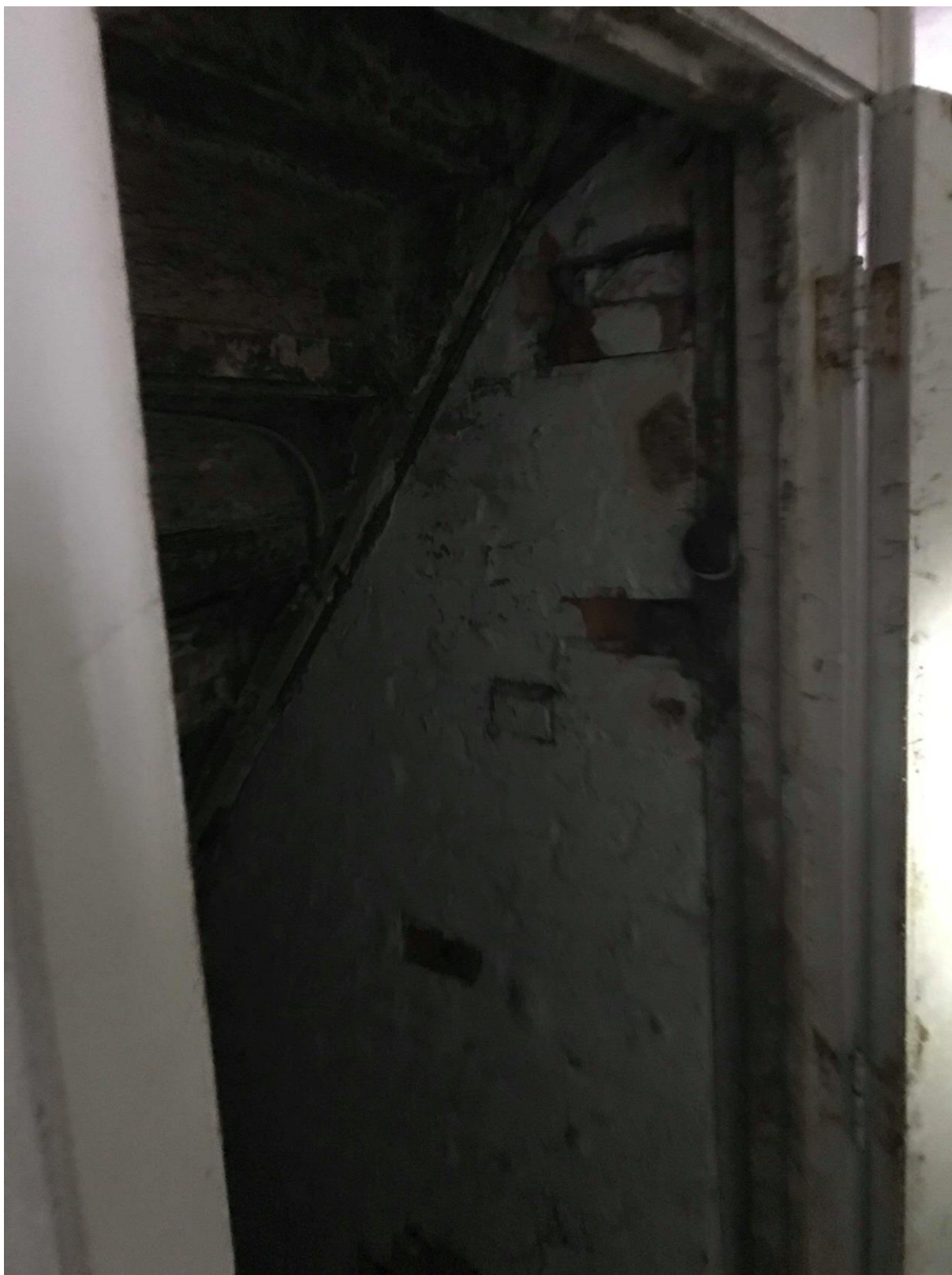
Figuur 8: Ingang kelder woonhuis 10 14
