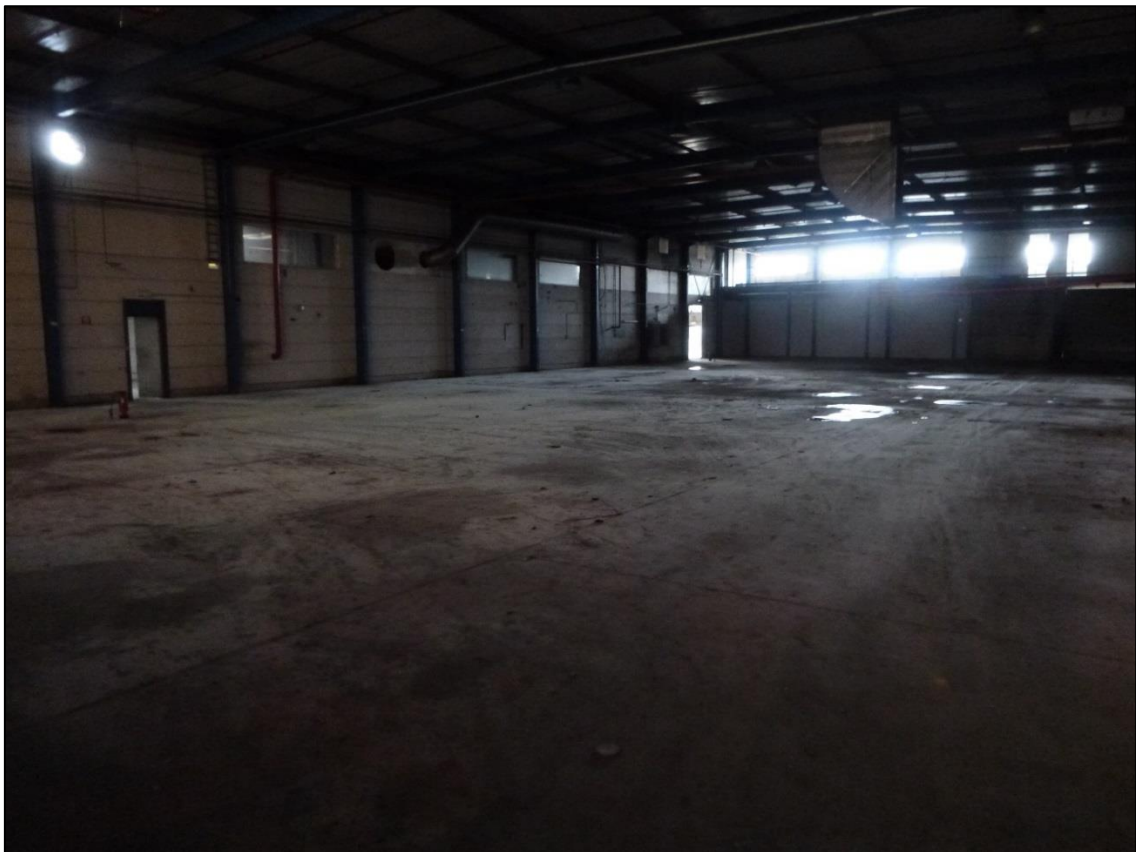
Figuur 13: Foto van de binnenzijde van het te slopen gebouw (ABO nv 2019)
