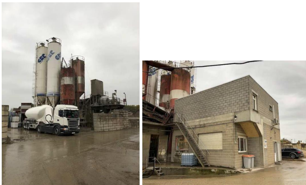
Figuur 4: Huidige toestand, betoncentrale en burelen ( H. Keulen Beton NV, 2019)
