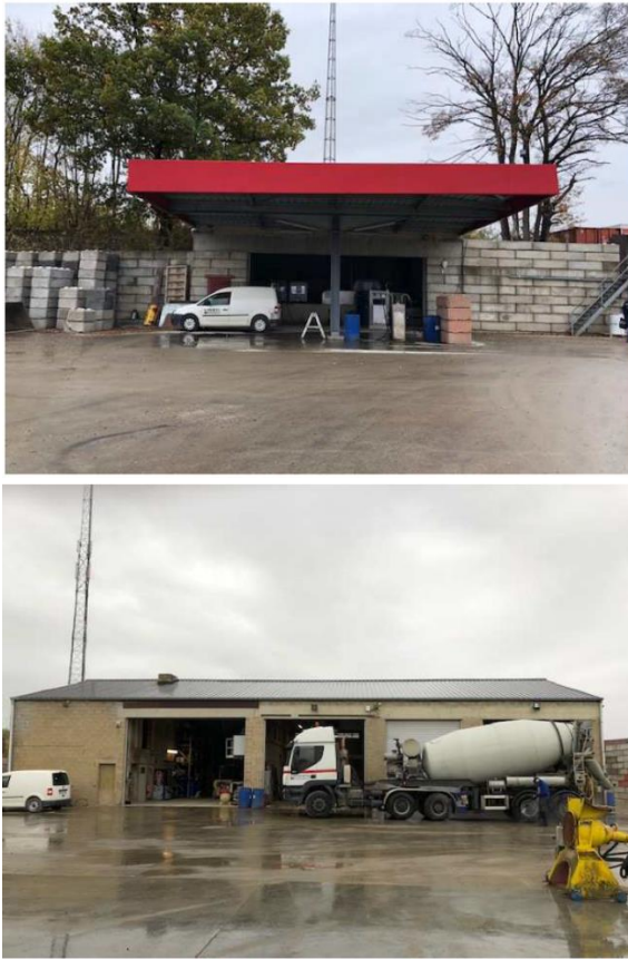
Figuur 7: Huidige toestand, tankstation en werkplaats (H. Keulen Beton NV, 2019)
