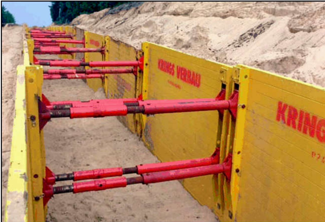
Afbeelding 1: Typevoorbeeld van kringbeschoeiing.
