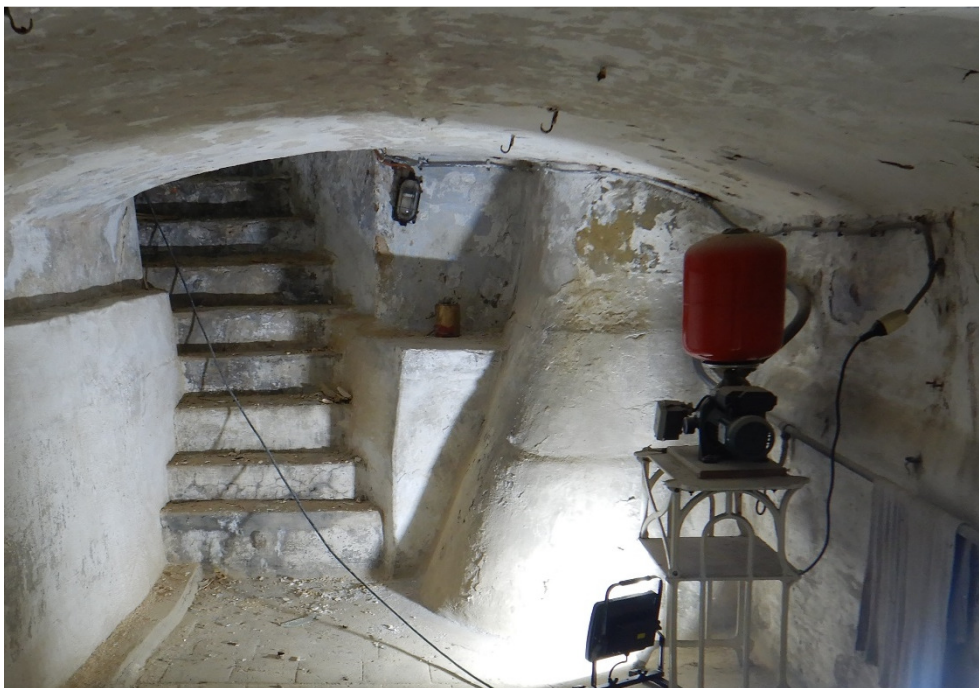
Figuur 10. Zicht op de keldertoeegang en de afgedekte waterput.
