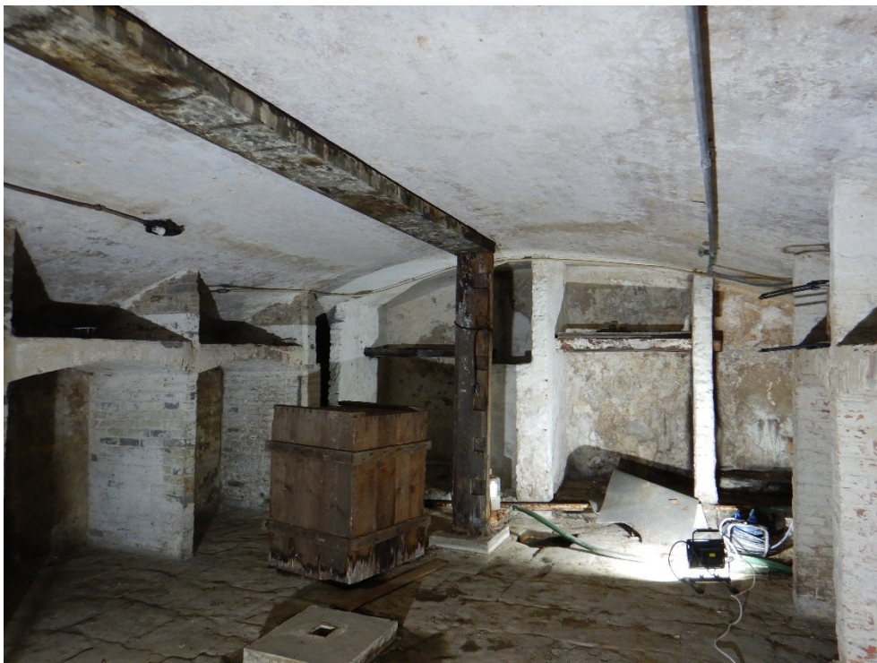
Figuur 12. Zicht op de noordwestelijke hoek van de kelder met centraal de houten constructie.
