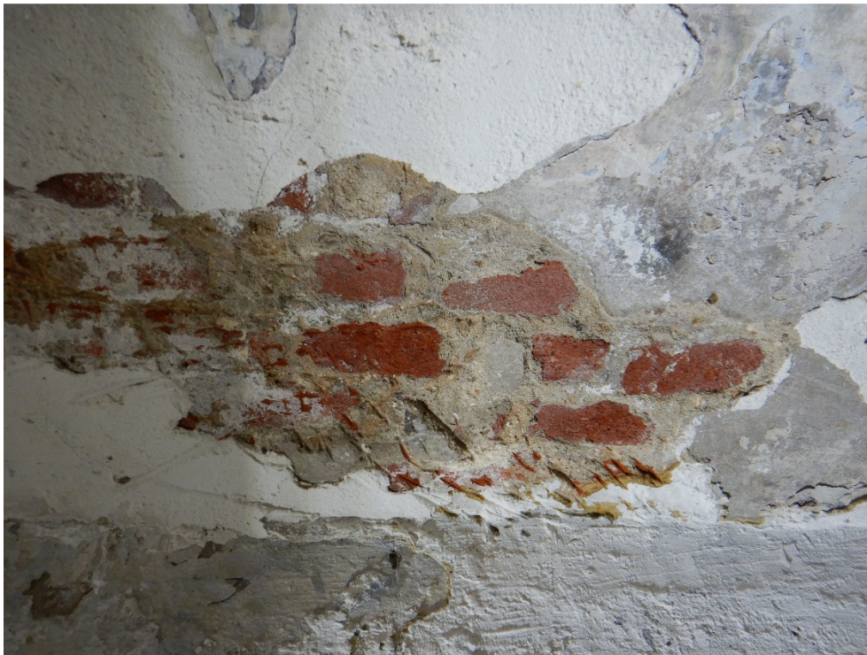
Figuur 8. Zicht op de baksteenconstructie van het segmentgewelf.
