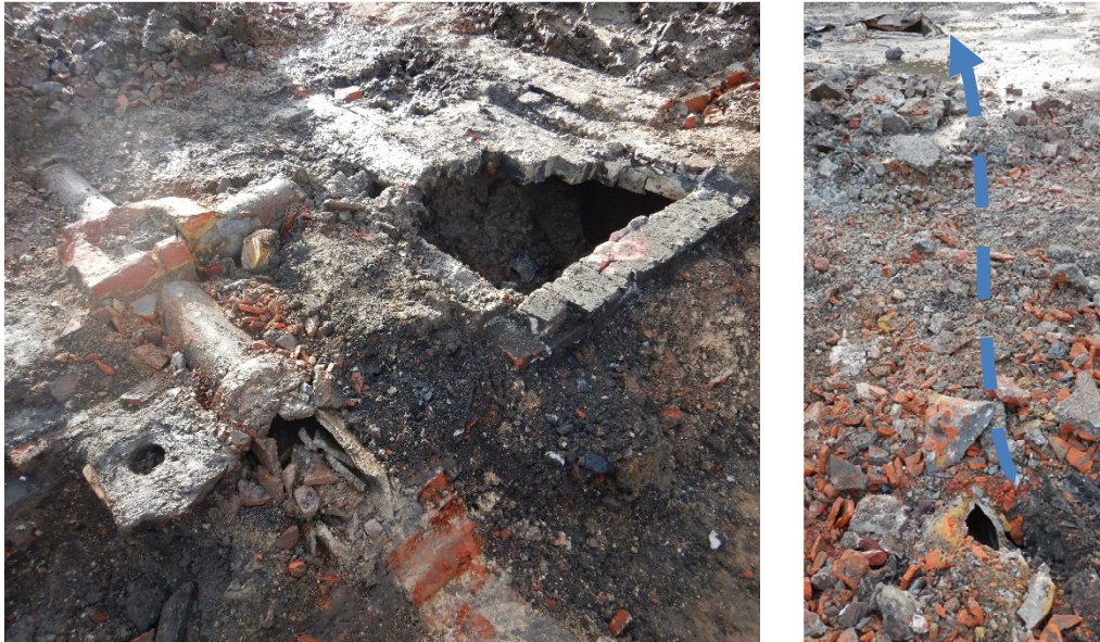
Figuur 14. Zicht op de bezinkbuis en grèsbuis in de proefput (links) en de grèsbuis en de bezinkput buiten de proefput (rechts).
