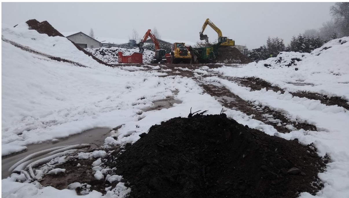
Figuur 28: Noordoostelijk zicht vanaf de westelijke hoek, nabij boring 4. (@BAAC)
