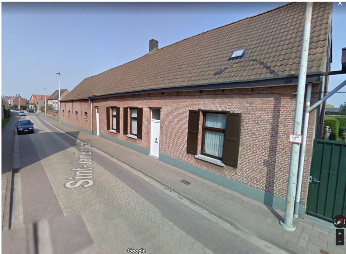
Figuur 3. Foto met zicht op de bestaande woning. ©GOOGLE MAPS.
