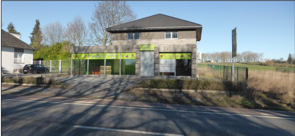
Figuur 13: Te slopen gebouw aan de noordzijde van de Maastrichtersteenweg
