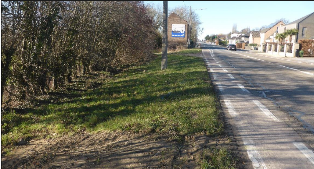
Figuur 10: Strook ten zuiden van Maastrichtersteenweg met centraal de te slopen woning
