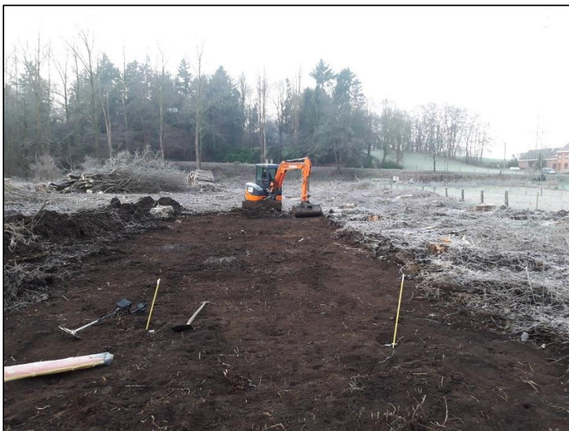
Foto 1: Voorbereiding van de proefsleufzone met behulp van een minikraan.
