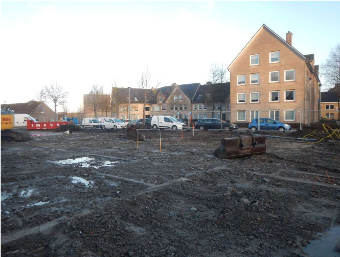
Figuur 22. Zicht op het plangebied met de nog veel aanwezige recente funderingen.
