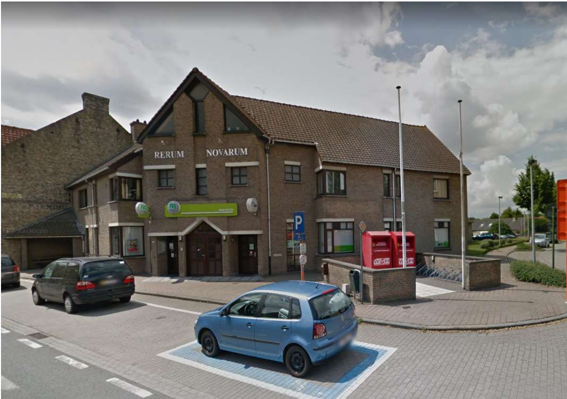
Figuur 17. Zicht op de gebouwen van de CM voor de afbraak. (bron: google)
