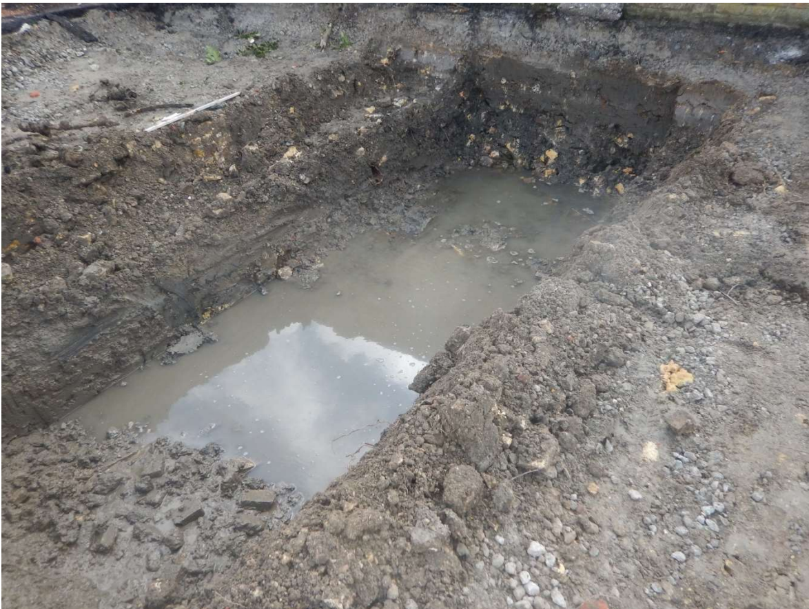
Figuur 23. Sleuf 3 liep bij de aanleg vrijwel onmiddellijk onder water.
