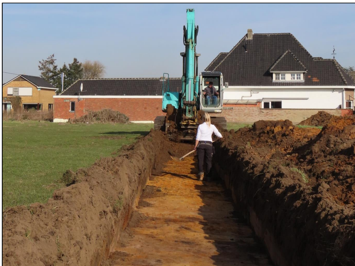
Figuur 8 Sfeerbeeld tijdens de aanleg van sleuf 4.
