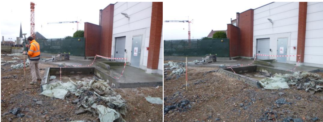
Afb. 6. Foto van de betonnen put met de originele plaats van het hoekpunt links en de nieuwe plaats rechts.
