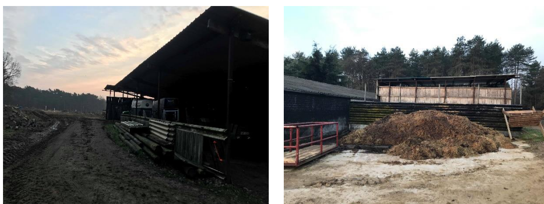
Figuur 5: Weergave van zijaanzicht en achterkant van schuur. Achteraan bevindt zich een mesthoop op betonnen verharding 9 (© J. Verrijckt bvba)
