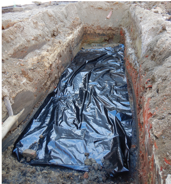
Figuur 21. Afgedekte sporen vooragaand aan het dichten van de proefsleuf.
