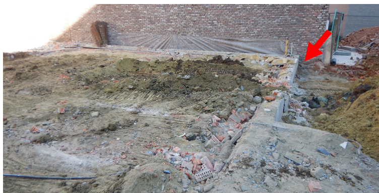
Figuur 3. De funderingsbalken .
