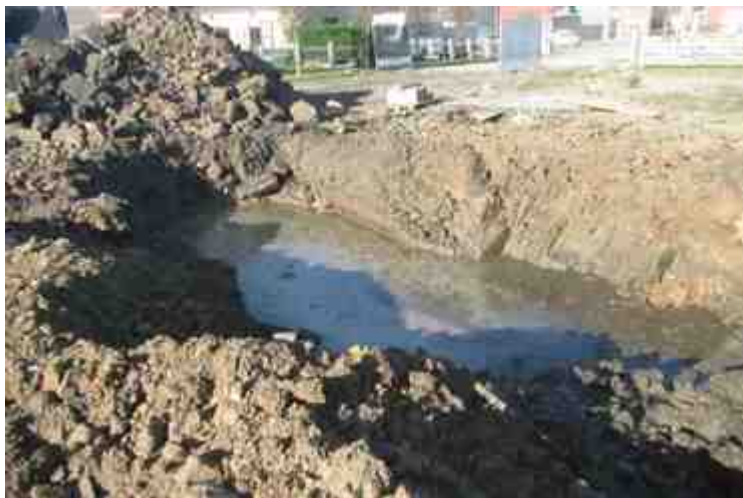
2018J332-0041.JPG - Spoornummer(s): / - Inventarisnummer(s): / - Structuur: / - Zone/Werkput/Kijkvenster/Vlak: 1///
