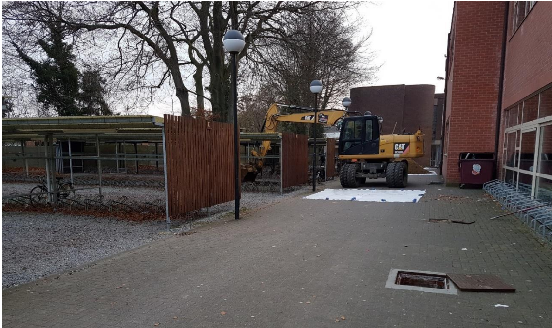
Figuur 5: zicht vanuit het westen op de zone met fietsstallingen. Op de voorgrond de deksels van de riolering en waterverzamelput. Tussen de fietsstallingen werd telkens een proefput aangelegd.
