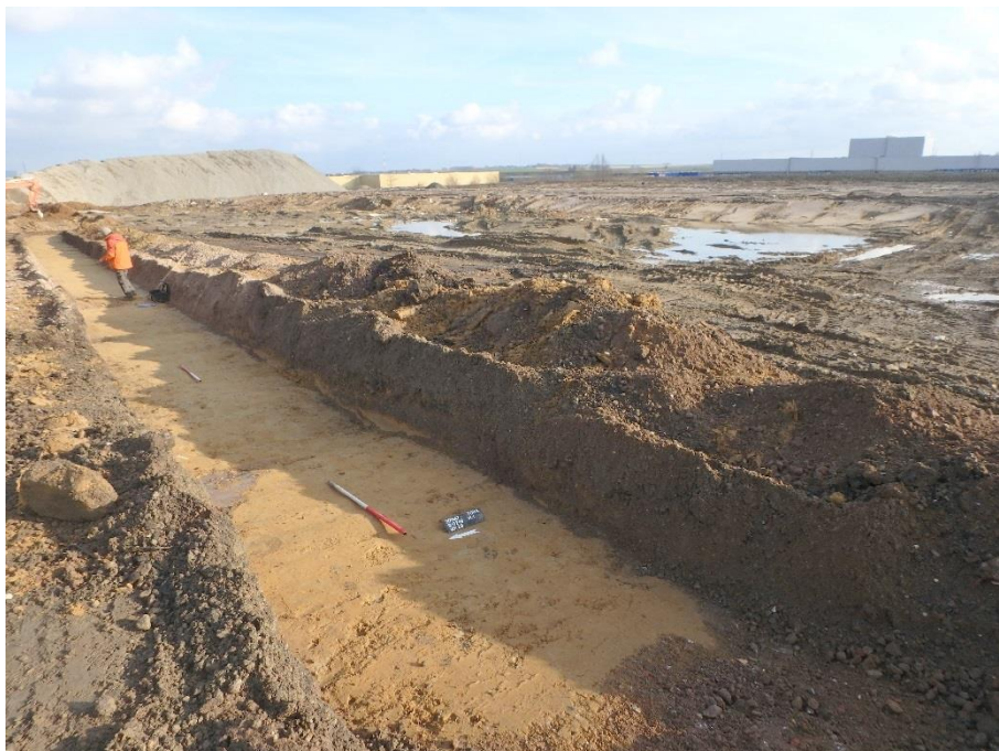
Figuur 7: Zicht vanuit het noordwesten op de noordelijke loskade na afbraak met werkput 29 op de voorgrond. © Devroe bvba 2019
