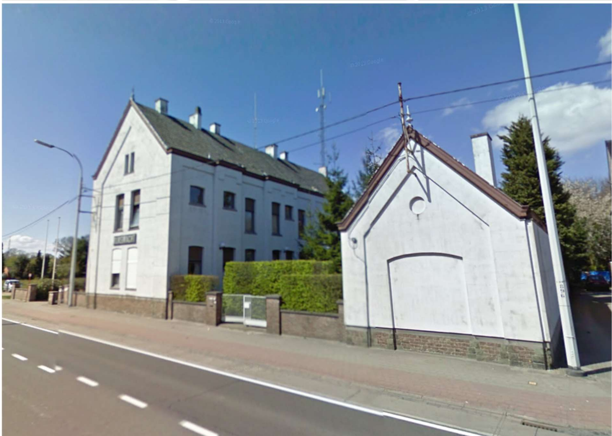
Figuur 3. Zicht op de voormalige rijkswachtkazerne. © GOOGLE MAPS
