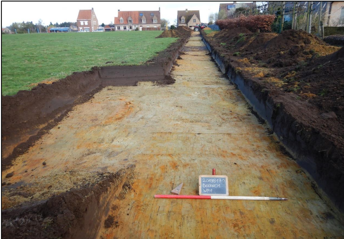
Figuur 22 Zicht op sleuf 1 in noordelijke richting.
