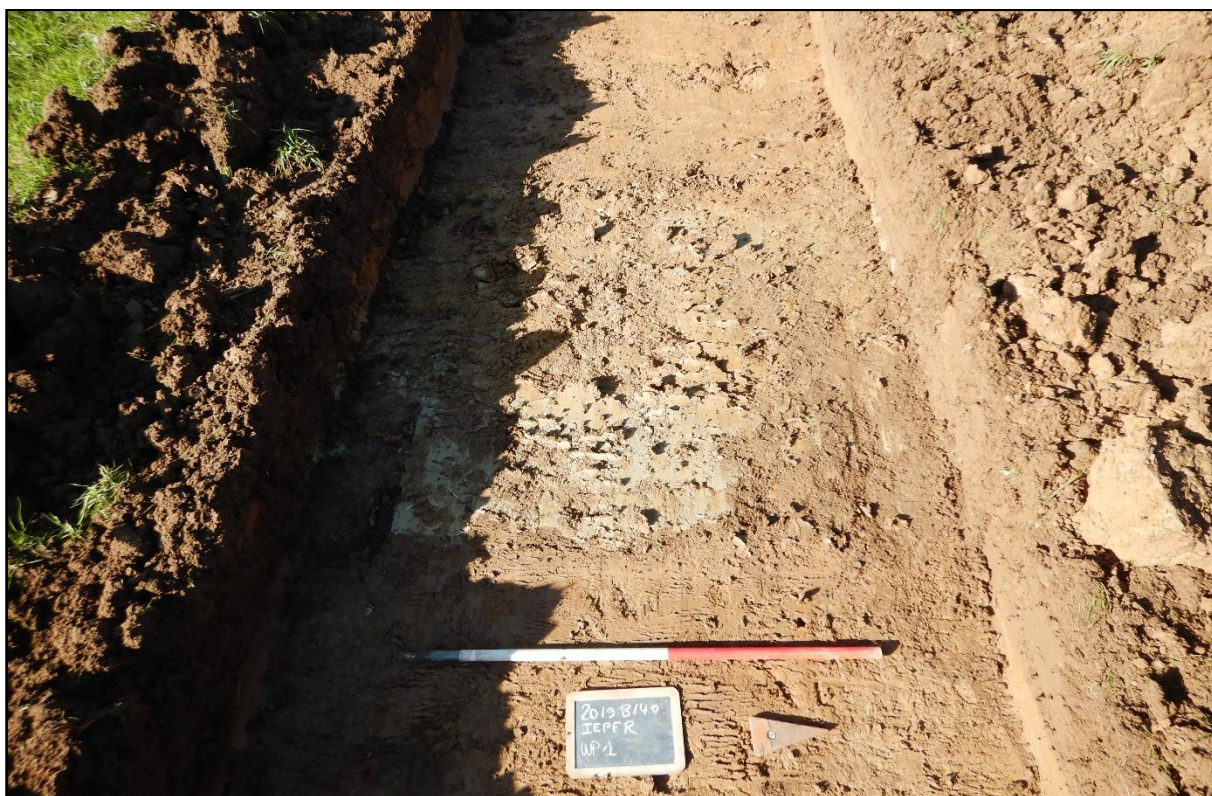
Figuur 23 Zicht op de rechtlijnige uitgraafsleuf voor de waterleiding (uiterste oosten van sleuf 1).
