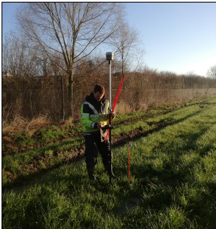
Figuur 5 Uitzetten van de metalen anomalieën ter hoogte van de proefsleuven op basis van het geofysisch onderzoek.
