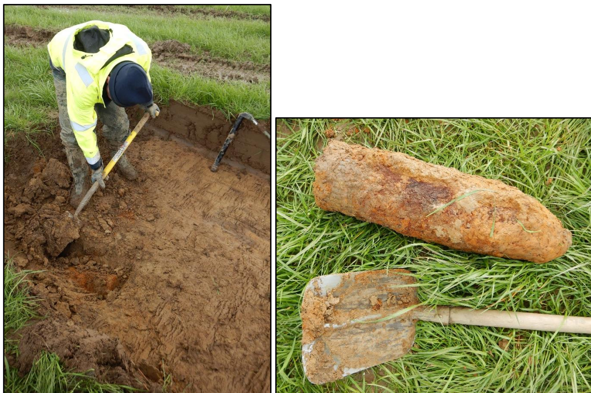
Figuur 31 Benaderen en veiligstellen van een Britse 6inch.
