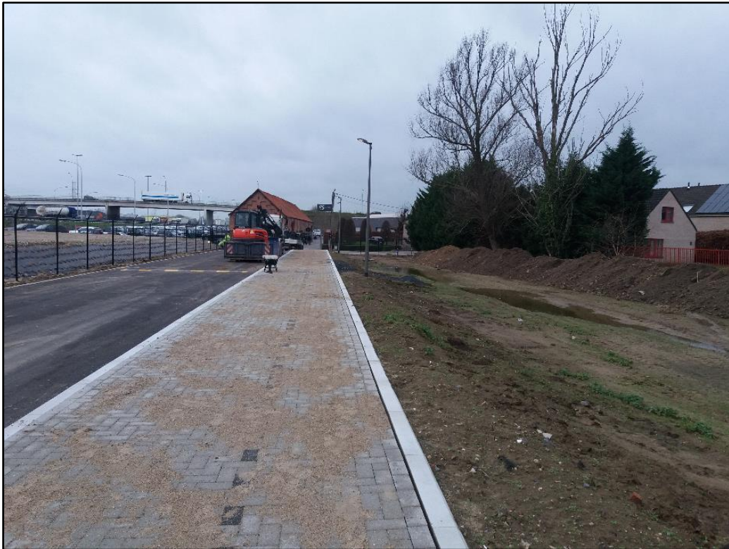
Figuur 6: Toestand van het terrein op 30 januari 2019 gezien vanuit het oosten: nieuwe weg en duidelijke terreinophoging (ABO nv 2019)
