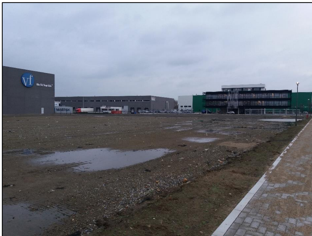
Figuur 2: Algemeen zicht op het onderzoeksgebied vanuit het westen (ABO nv 2019)
