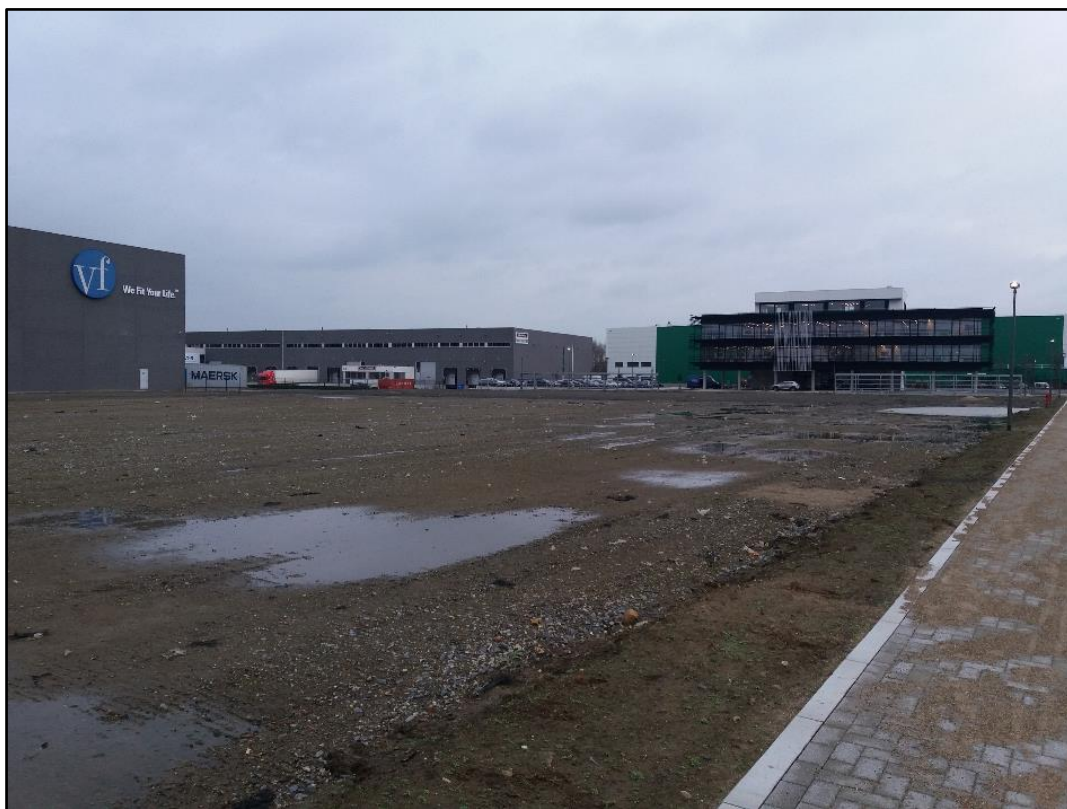
Figuur 7: Toestand van het terrein op 30 januari 2019 gezien vanuit het westen: ophoging en nivellering (ABO nv 2019)
