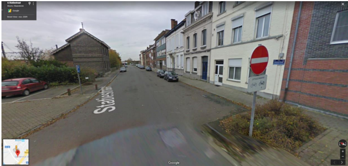
Figuur 25: Zicht op de Statiestraat (Zone 2 vanuit het zuidwesten) (bron: GOOGLE, 2019).
