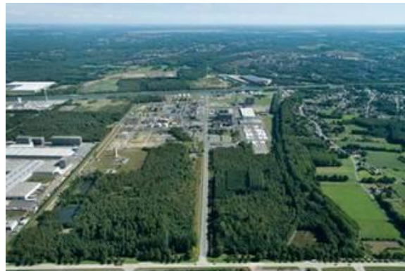
Figuur 6: Zicht op het terrein vanuit het westen. (Bron: opdrachtgever, 2018).
