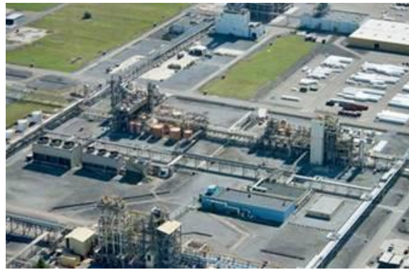
Figuur 10: Zicht op het terrein vanuit het oosten: detail. (Bron: opdrachtgever, 2018).
