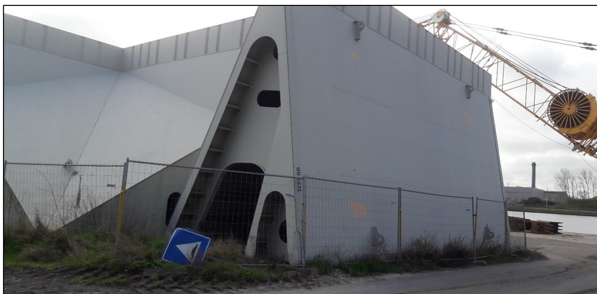
Figuur 22 : Zicht op het plangebied ter hoogte van de oorspronkelijke locatie van boring 6, gezien vanuit het westen.
