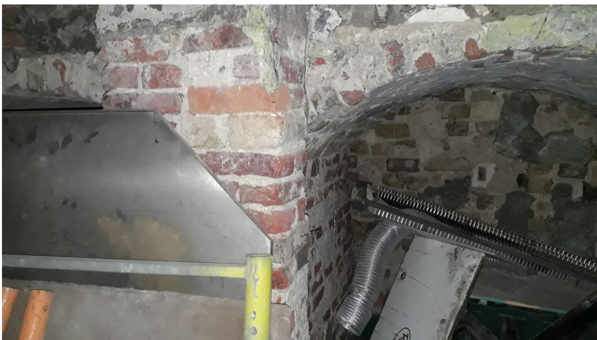
Figuur 34 Zicht op de spaarboogopeningen in kelderruimte 1. (bron: erkend archeoloog)
