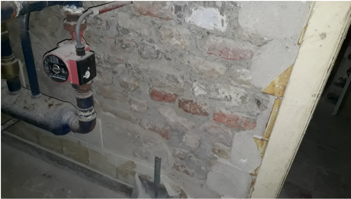
Figuur 37 detail op het metselwerk in kelderruimte 3. (bron: erkend archeoloog)
