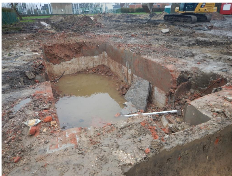
Figuur 9: De aanwezige kelder met de aanleg van sleuf 5 ten oosten en ten westen van de kelder.
