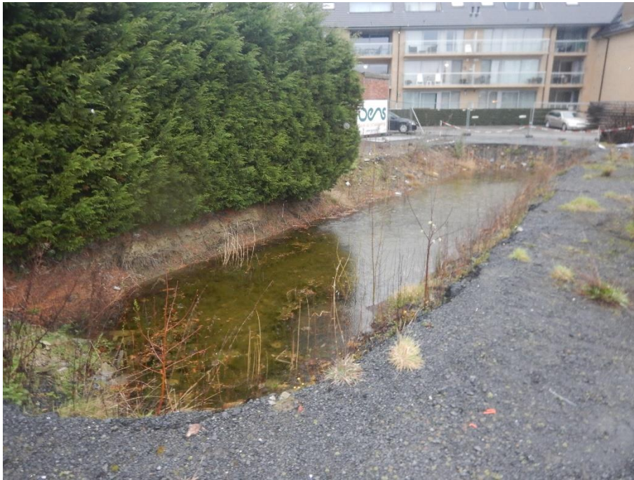
Figuur 4: De uitgegraven zone waar de weegbrug zich vroeger bevond.
