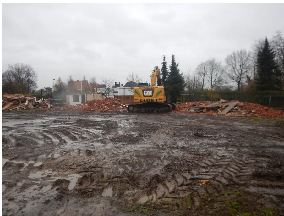
Figuur 3: Zicht op de afbraak van de gebouwen en het oostelijk deel van het terrein, foto vanuit het noorden.
