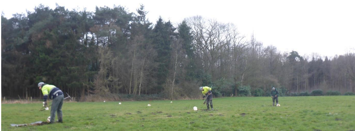
Figuur 65: Overzicht tijdens de werkzaamheden (GATE).
