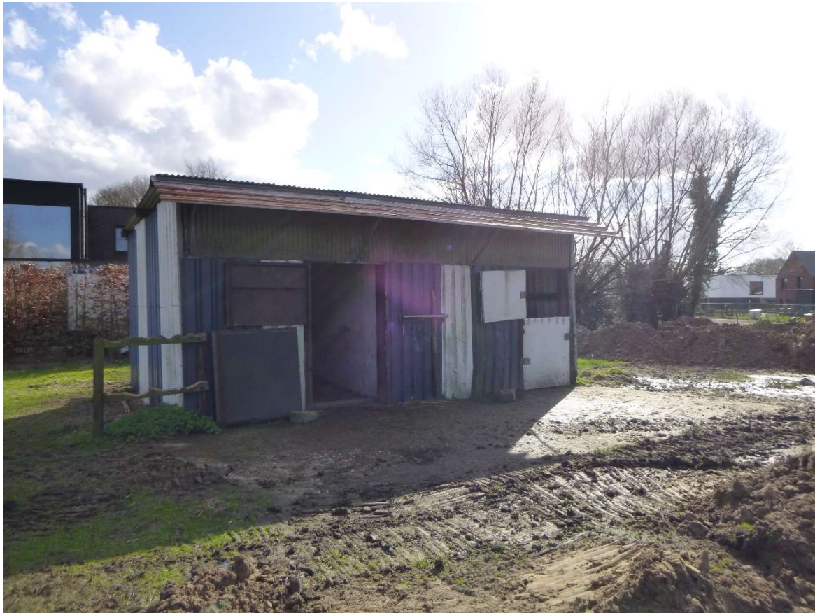
Figuur 15. Stal aan de zuidelijke perceelgrens van het plangebied.
