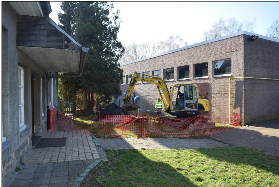
Afb. 47: Aanleg PP1 met op de achtergrond de turnzaal, foto genomen uit het noordwesten thv blok C.
