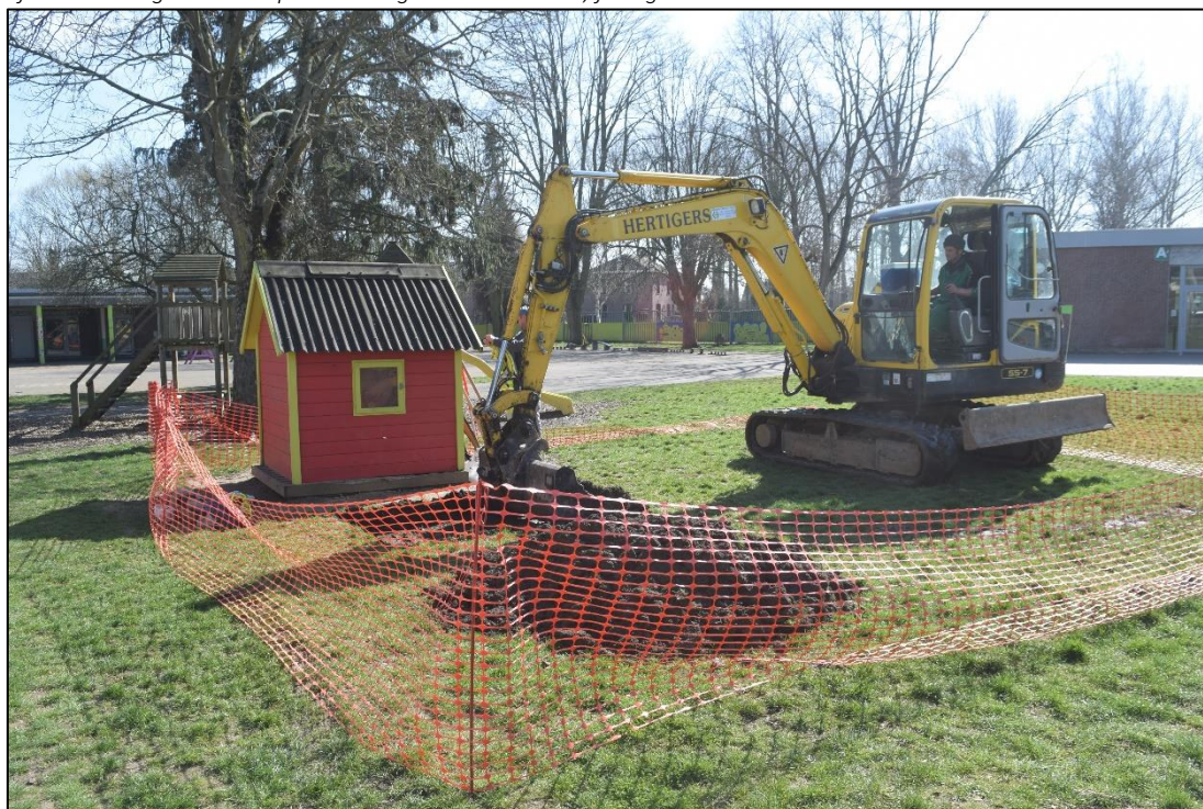
Afb. 48: Aanleg PP2, foto genomen uit het noordwesten.
