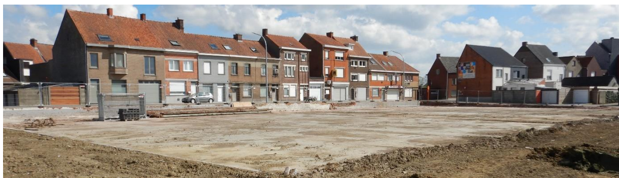
Figuur 7: Vloerplaat in het zuidoosten
