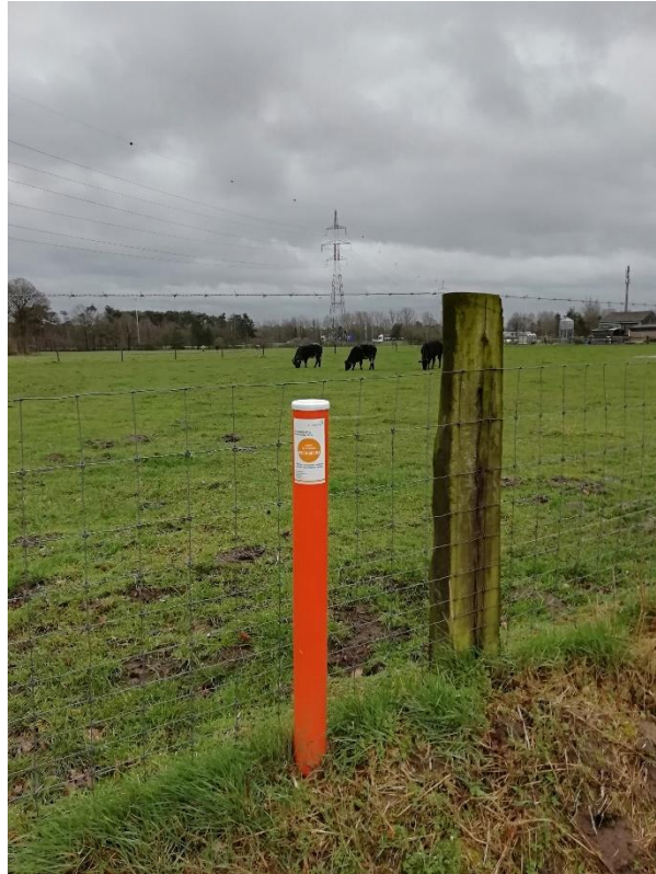
Figuur 25: Foto van de markering van de hogedruk aardgasleiding en de afrastering van perceel 839X4
