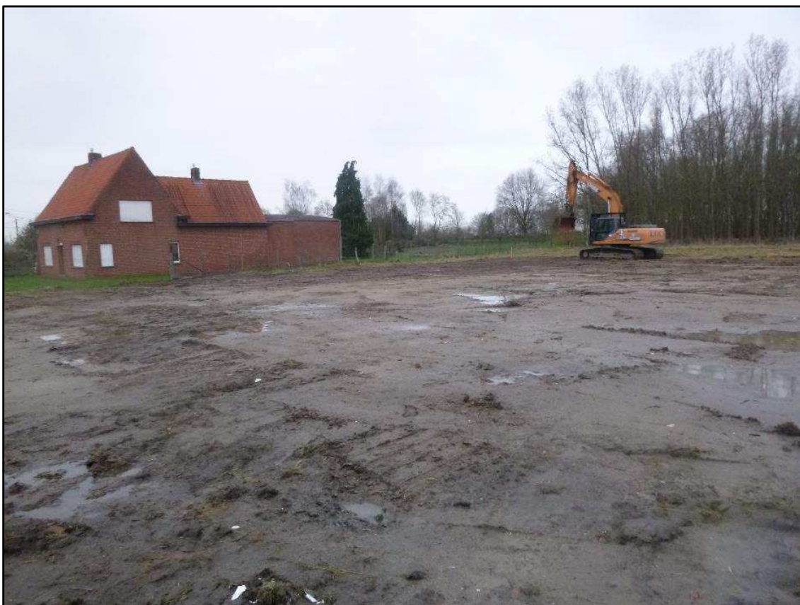
Figuur 20: Toestand van het terrein na de afbraak en archeologische sloopbegeleiding (ABO nv 2019)
