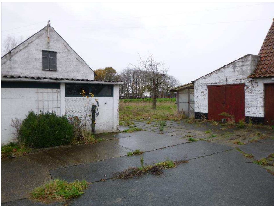
Figuur 7: Bijgebouwen en verhardingen voor de afbraak (ABO nv 2019)
