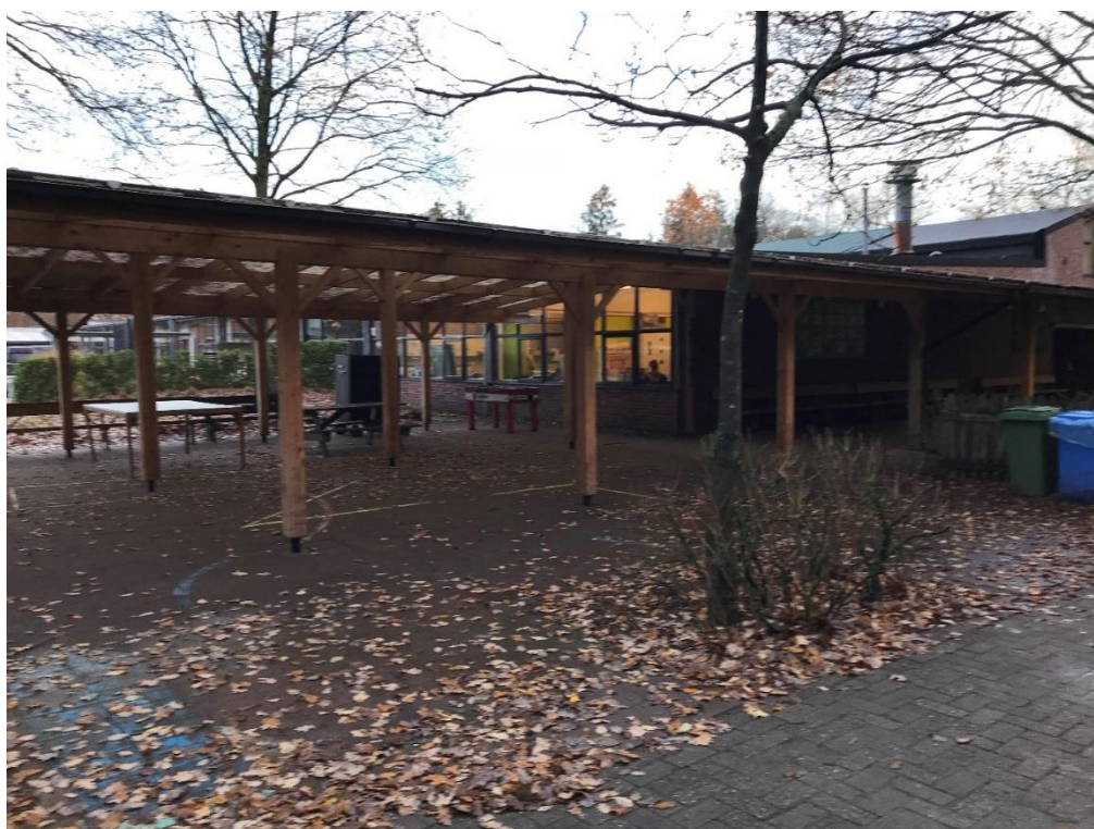
Figuur 23: Achter- en zijgevel van het bestaande schoolgebouw. Deze overdekte plaats met banken blijft behouden. (© J. Verrijckt Archeologie & advies Bvba)
