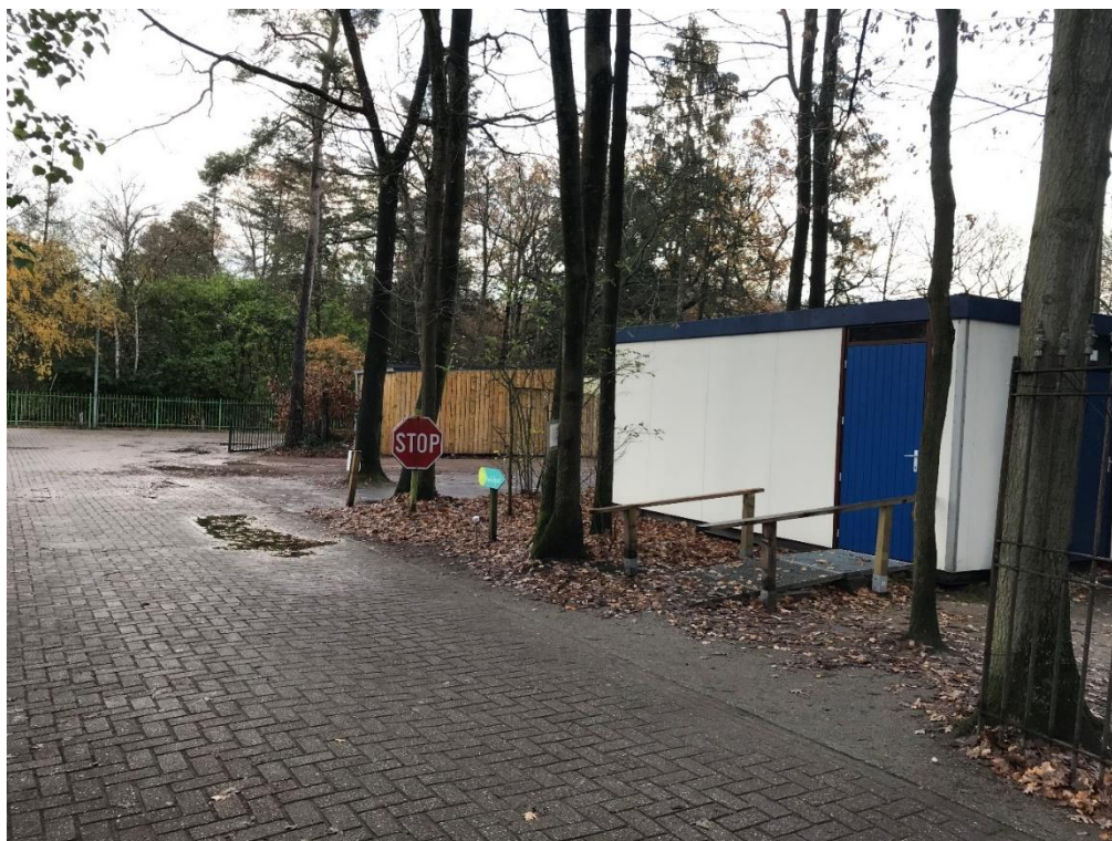
Figuur 4: Huidig gebruik: containers met wegenis in tegels naar Oude Arendonkse Baan. Aan rechterkant houten constructie (milieupark) met inrit parking. De containers zullen worden gesloopt. De verharding zal opnieuw worden aangelegd. Het milieupark zal behouden blijven. (© J. Verrijckt Archeologie & advies Bvba)
