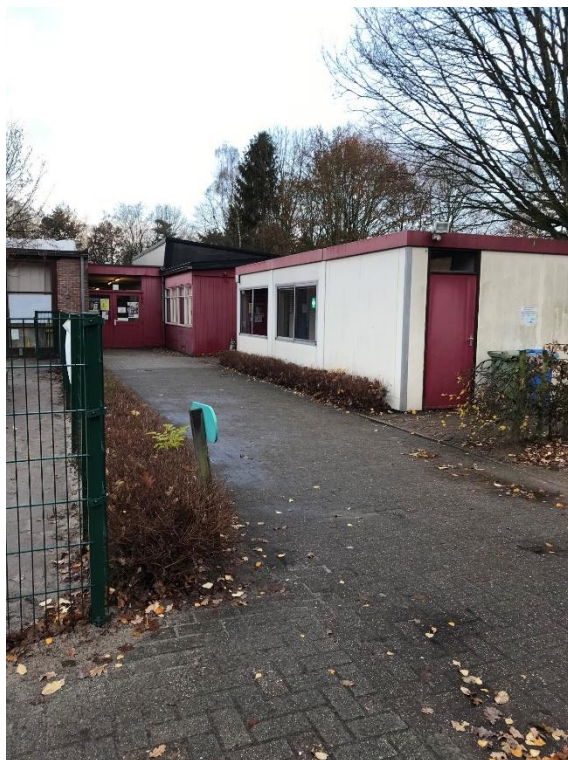
Figuur 14: Witte en rode container die zich situeren aan het bestaande schoolgebouw. Beide containers zullen worden afgebroken. (© J. Verrijckt Archeologie & advies Bvba)
