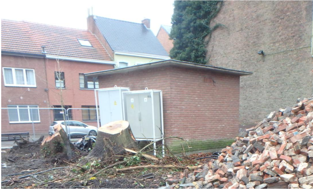
Afb. 12. Boomwortels en elektriciteitscabine ter hoogte van spoor 6.
