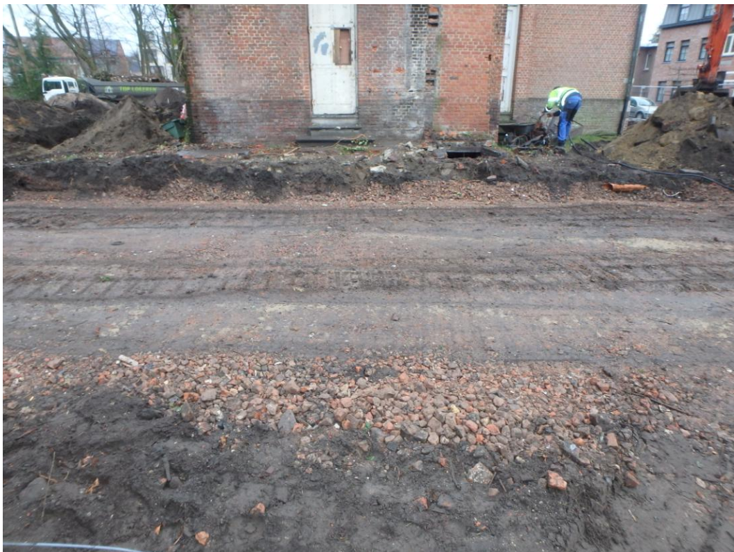
Afb. 11. Verharding ter hoogte van sleuf 6.
